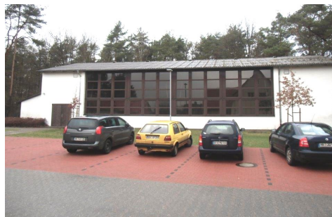
Mehrzweckhalle in Trauen
